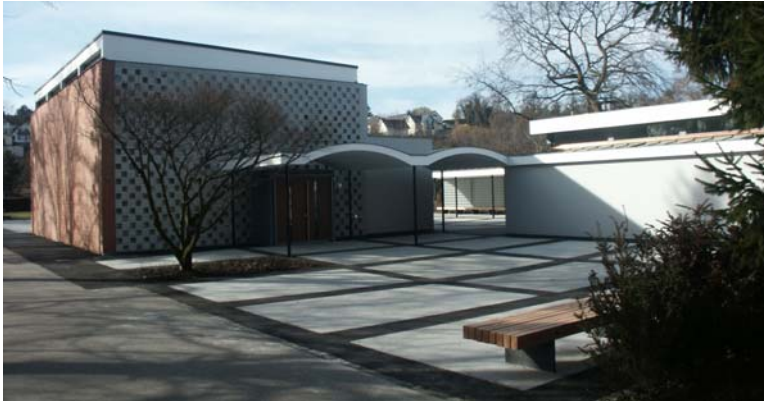
Renovierte Friedhofkapelle und Betriebsgebäude
