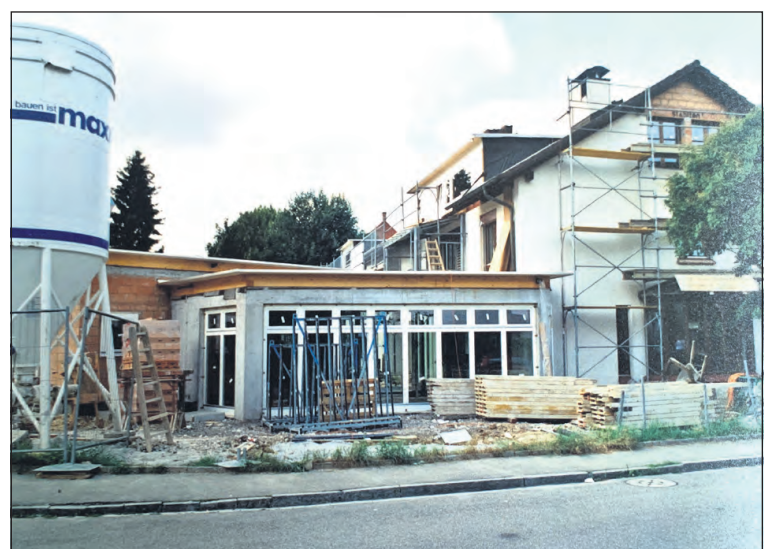
Work in Progress: Das modernisierte Dr. Augustin-Haus nimmt langsam Form an.
