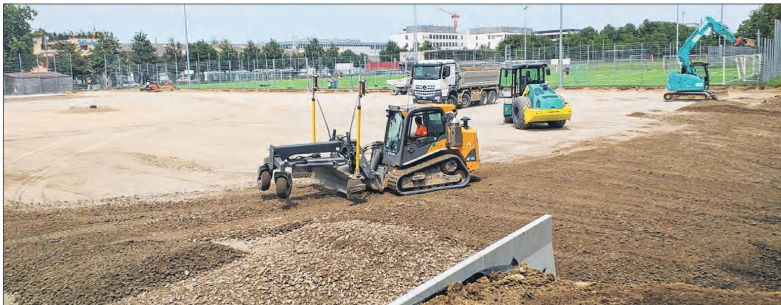
*Unter einen Kunstrasen gehören verschiedene Materialschichten, die für Stabilität und eine optimale Drainage sorgen.*
